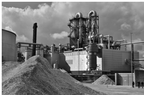
Abbildung 4. ExergyPSSD (Dampftrockner mit überhitztem Dampf) für die Trocknung von Holzpellets.
